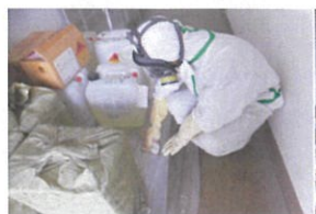
现场收集处理
